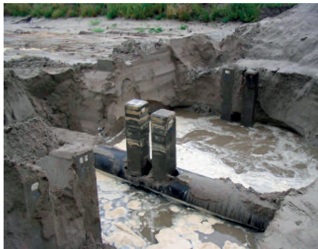
Heipaal doorboort leiding
